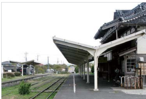
レールやホームが残る大社駅跡。現役時代には、大都市から来た多くのお客が降り立ったことでしょう。
