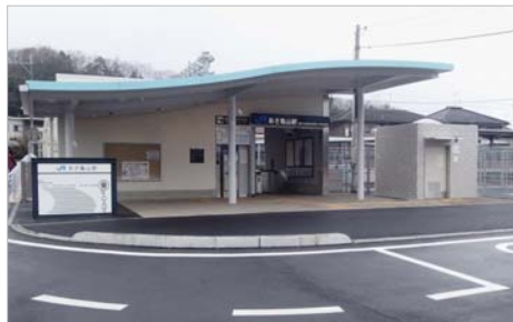
あき亀山の駅舎。駅周辺は開発途上といった感じですが、将来的には市民病院が建設されるそうです。
