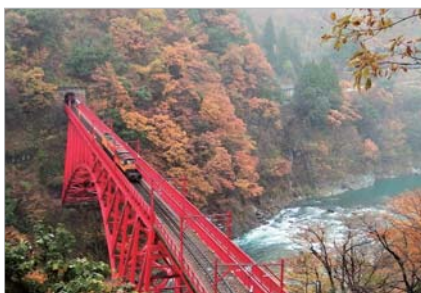
宇奈月駅近くの展望台から見る新山彦橋。晩秋とはいえ雪がちらつく天候でした。ちょうど橋の上を短い貨物列車が走っていきます。
