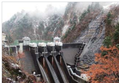
黒部川に設けられた出し平ダム。下流の宇奈月湖にある新柳橋発電所などへ送水しています。ここまで来ると山の斜面にも雪が見られます。
