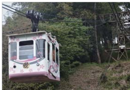
吉野山のロープウェイは春から運行を再開しました。右後ろに見える鉄塔は昭和3年に建設されたもので、機械遺産にも指定されています。
