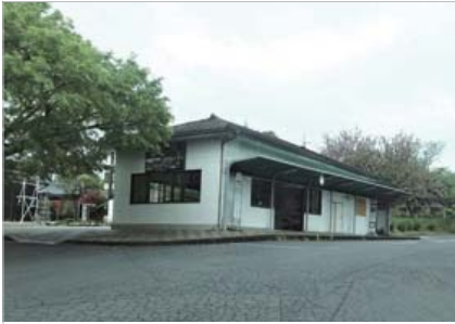
廃止されたケーブルカーの信貴山駅の駅舎。今でもバス停の待合室として使われています。
