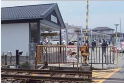
田原本駅（手前は橿原線の線路）から田原本線の西田原本駅（台形の黒い屋根）を望む。同じ近鉄線ですが、改札を出て乗り換える必要があります。
