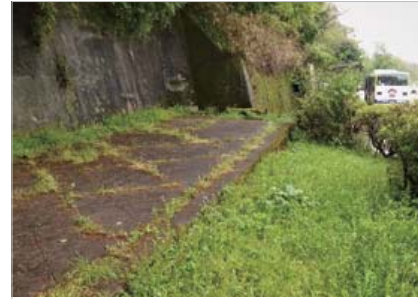
西信貴ケーブルの高安山駅の駅前にある山上鉄道のホーム跡。かつてはこんな山の上にも電車が走っていました。
