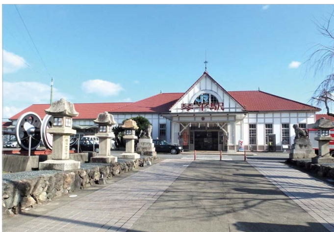
レトロな駅舎の琴平駅。この写真は3年ほど前に撮影したのですが、この後、大正時代に建てられた当時の姿に修復されています。
