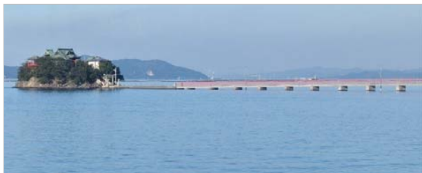
観音寺行きは多度津駅で高知方面の土讃線と分かれ、松山方面へ向かう予讃線に入ります。車窓には瀬戸内の景色が広がります。写真の津嶋神社は 8 月の大祭の 2 日間以外は渡ることのできない島に本殿があり、大祭の日には臨時駅の「津島ノ宮駅」が営業します。
