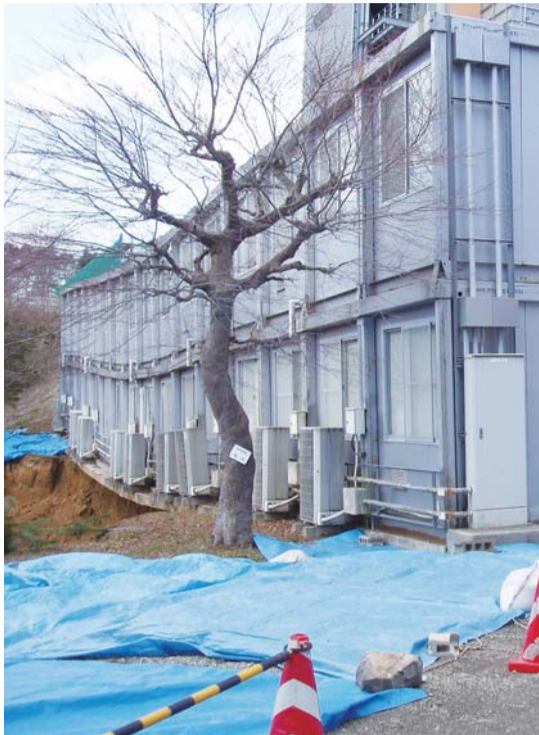
【東北大学構内の被災状況】 左：工学研究科支部書記局は1階手前の角（建物が歪んで戸があかず、物も取り出せない。シート下の地面にも亀裂が入っており崩落しそうな状態）。右：理学研究科・化学棟の7階の実験室（火災）。（撮影：東北大学職員組合）
